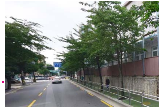
북측도로(풍성로, 8m) : 보행로와 차로 학교로의 출입구 없음, 용벽담장설치
